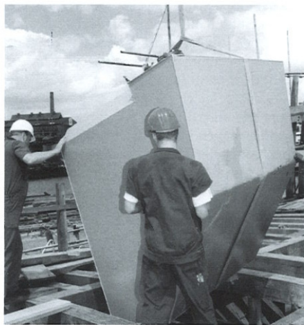
Ein Treibstofftank wird durch die Ladeluke eingebracht
