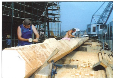
Schwerstarbeit bis der Mast rund ist
